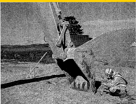
バックホーで施工後、測量して誤差などを確かめた
