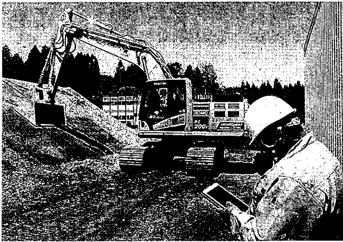
同社モータープールでのICT施工デモの様子。タブレットやPCによる遠隔地での施工管理も容易だ
